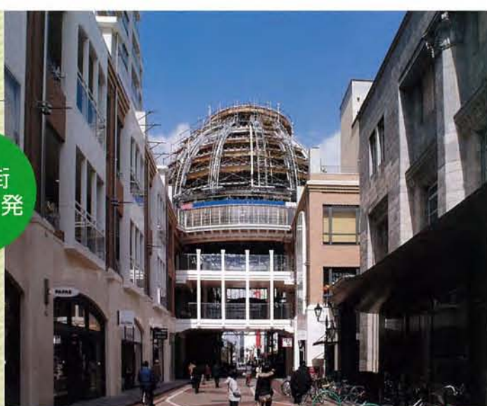
壹番街に姿を現わした 工事中のドーム (2007年3月12日撮影)
