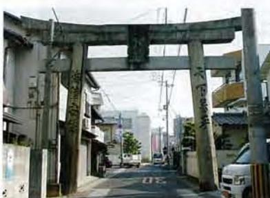
中府の大鳥居は、花崗岩で造られており、高さ約6.7m、柱の間約4.5mの立派なもの。額には「金刀比羅宮」、西の柱には「天下泰平」、東の柱には「海陸安穩」と刻まれている
