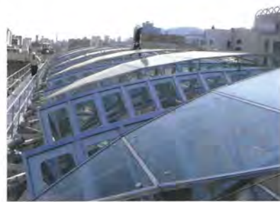
アーケードの天井は開閉式で、風がよく通る構造になっている
